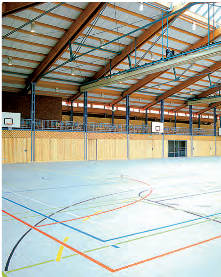
Jahnsporthalle Verden, verantwoordelijke instantie: Stadt Verden
