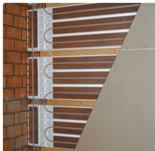
Uponor Siccus wandverwarming met droge afbouwplaten
