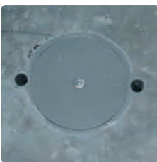
Aanzicht van onderen in gebetonneerde toestand
