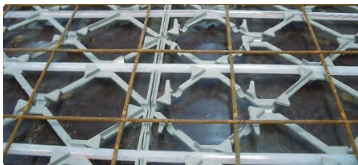
Uponor Contec ON standaardvariant dicht aan de oppervlakte geïnstalleerd op vloerbekisting.
