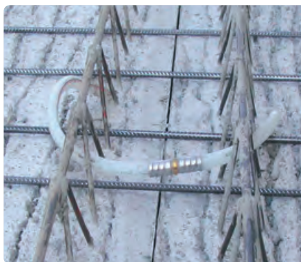
Verbinding van de Uponor Contec ON module door middel van onlosmakelijke Uponor perstechniek
