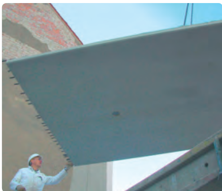
Neerleggen van de verdiepingvloerelementen
