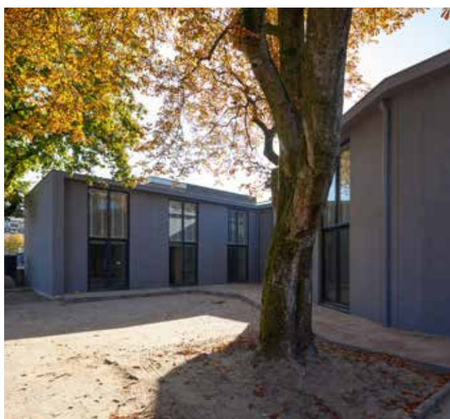
DE BOMEN OP HET TERREIN KONDEN BLIJVEN STAAN DANKZIJ CREATIEVE ARCHITECTUUR.
