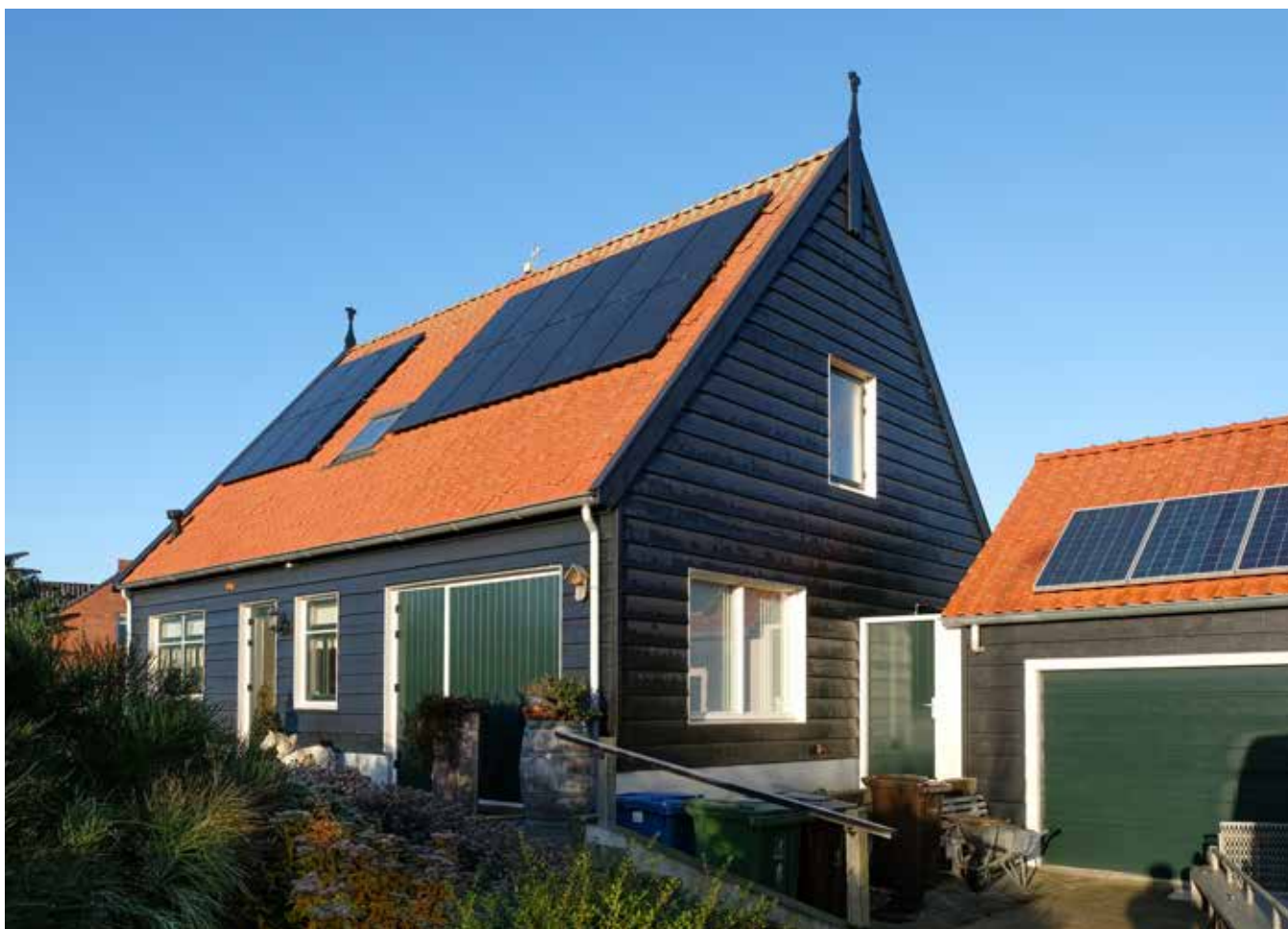
ENERGIEZUINIGE WONING: DE CV-KETEL IS VERVANGEN DOOR EEN ALPHA INNOTEK LWDV WARMTEPOMP EN ZONNEPANELEN ZIJN GEPLAATST.
