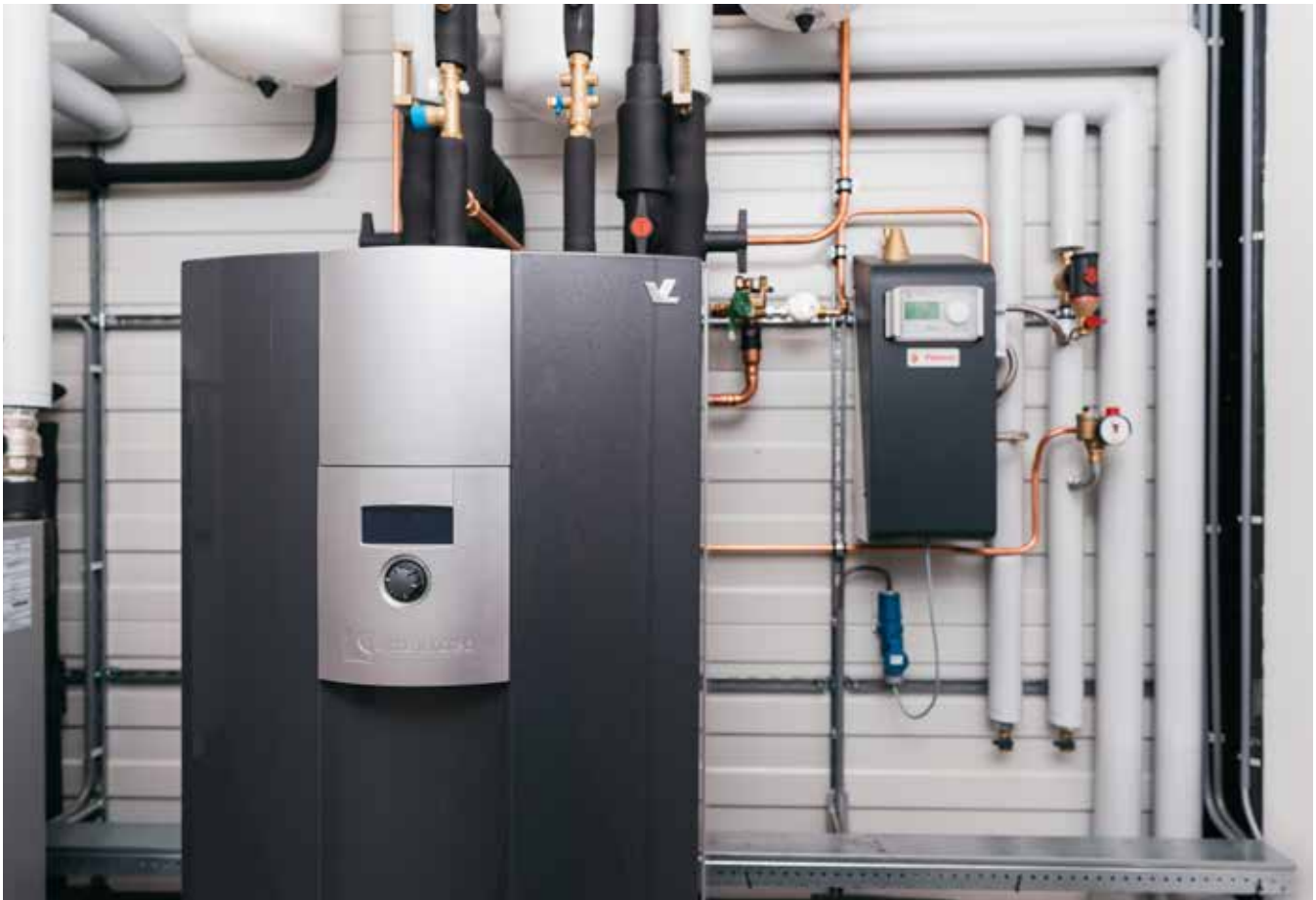
DE ALPHA INNOTEC ALTERRA ALS STRALEND MIDDelpUNT VAN DE TECHNISCHE RUIMTE.
